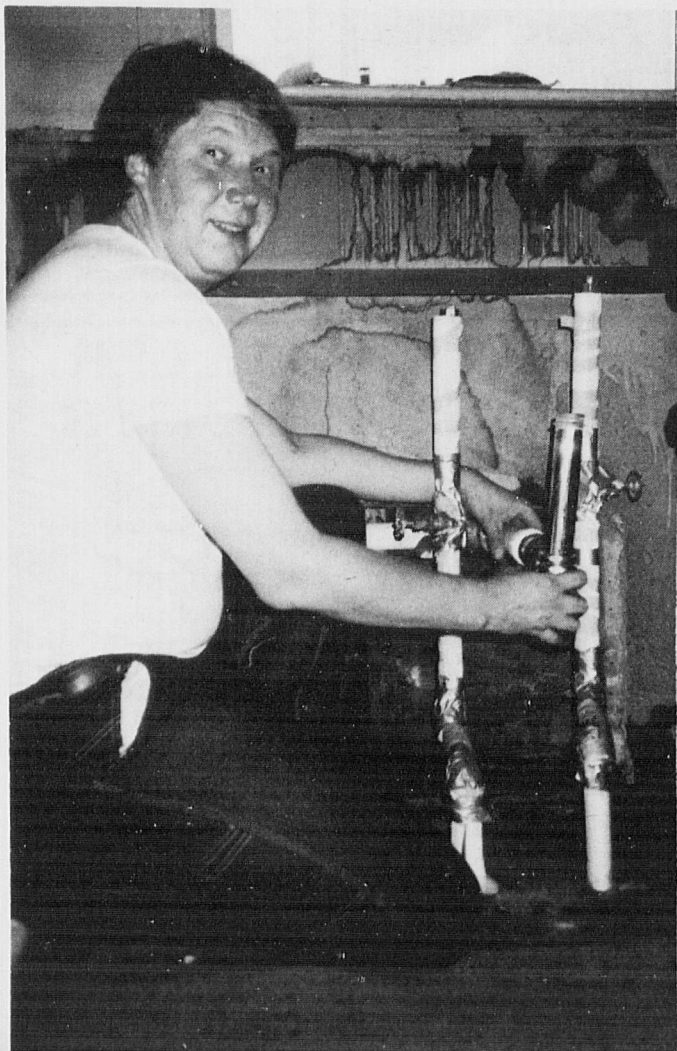
MONEN HATUN MIES - Jos joku vielä uskaltaa ehdottaa, että Raivaajassa työskentely olisi yksitoikkoista, niin tämä kuva todistaa, että takuulla on väärässä. Toimitusrakennuksen keittiön viemäriputki kun alkoi parisen viikkoa sitten vuotaa, niin liikkeenhoitaja Jonathan Ratila (kuvassa) sai vaihtaa liikkeenhoitajan hatun putkimiehen hattuun. Putki vaihtui uuteen ja vesi virtaa taas niin kuin pitääkin.
