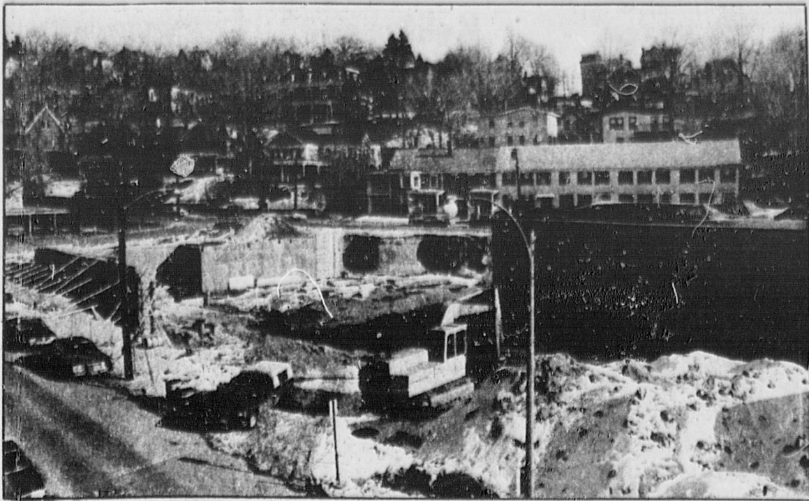
Kuvan etualalla Fitchburgin uuden poliisilaitoksen rakennustyömaa. Rakennuspuuhiin päästiin marraskuun alkupuoliskolla ja niiden on määrä jatkua läpi talven, jotta uusi rakennus valmistuisi aikataulun mukaisesti. Toiveena on muuttaa uuteen poliisilaitokseen tämän vuoden syksynä. Rakennustyömaan vieressä oleva 90-vuotinen nykyinen poliisilaitos puretaan uuden rakennuksen valmistuttua.
