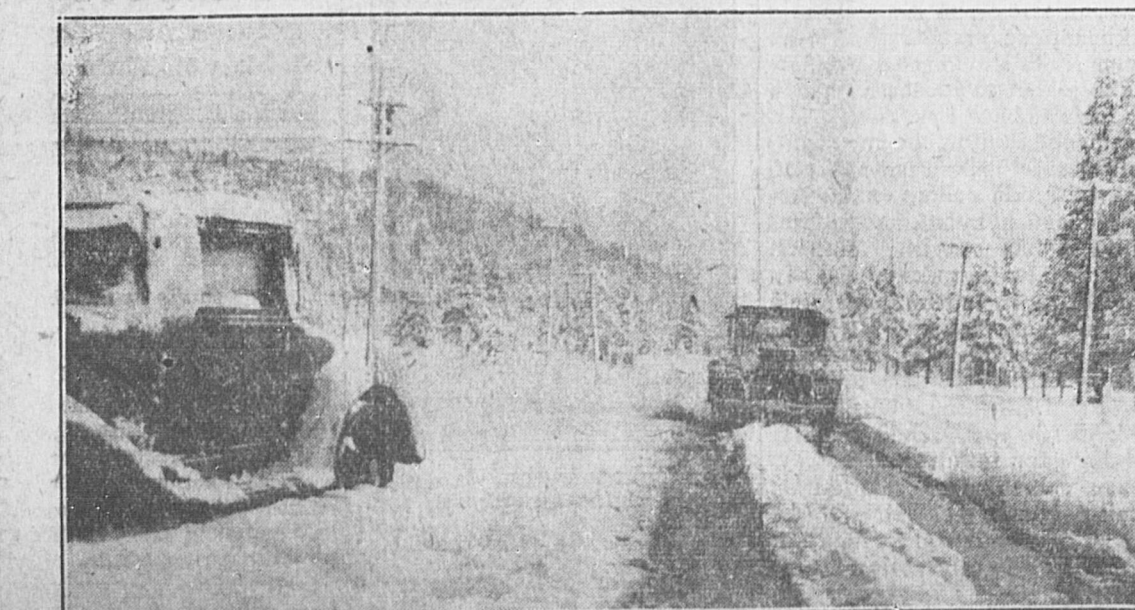
TALVI CALIFORNIASSA. Ensimmäinen lumi Nevada-kautissa California:ssa. Sitä tuli 12 tuumaa Truckeessa ja 17 tuumaa Donner Summitissa. Lämpömittailella keskeytyi 12 tunteksi. Ylläoleva kuva on otettu maantien Truckeessa.
