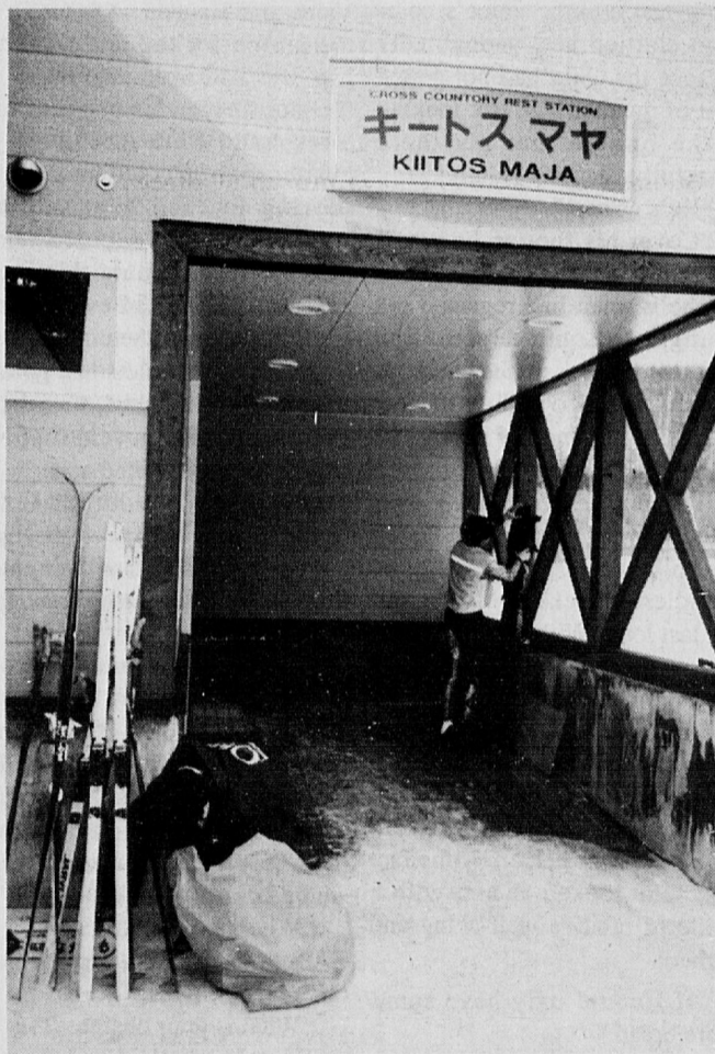
Ohtakin hiihtomaisemlin oli suomalaisidean pohjalta syntynyt pituushiihdolle huoltorakennus, joka oivallisesti nimettiin "Kiitos majaksi".
